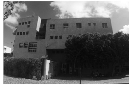
Fachada principal Instituto de Investigación y Posgrado.
