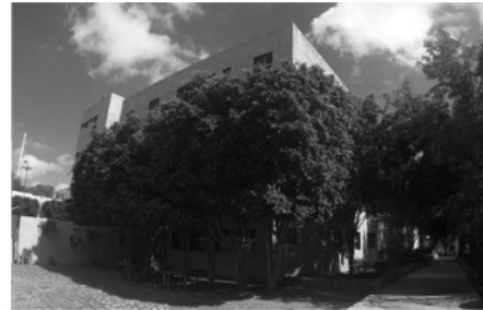
Vista lateral Instituto de Investigación y Posgrado.
