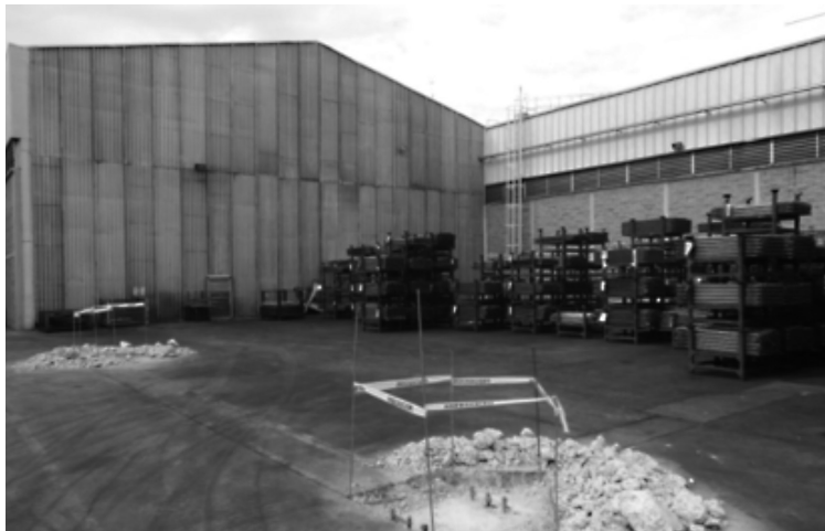
Figura 3 . Fotografía de área de ampliación de nave industrial. Fuente: LEAG.
