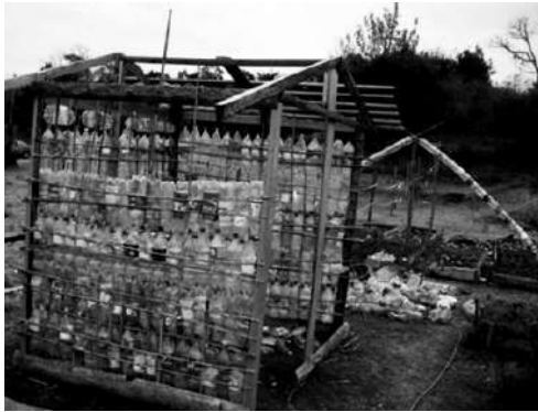
Fotografía No.3. Sistema constructivo Casa de Botellas PET-Construcción Alternativa. A.G.S.
