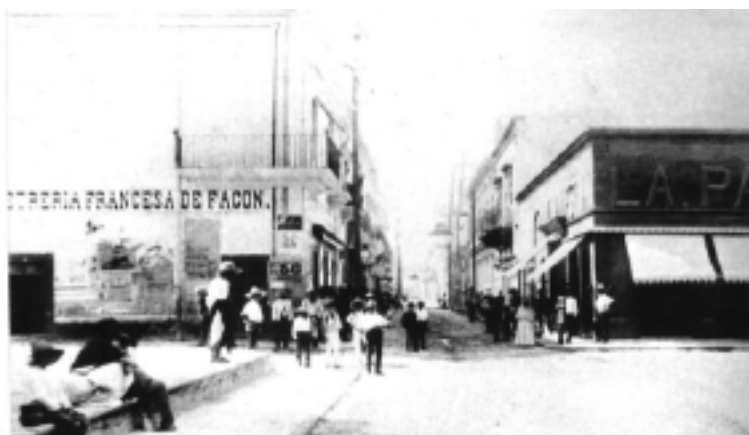
Imagen 1 Vista de la antigua casa que ocupa hoy el edificio San Rafael. Fuente: Archivo Histórico del Estado de San Luis Potosí.
