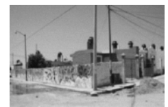
Figura 1, 2, 3 y 4. Viviendas de interés social deterioradas y abandonadas en Altamira Tamps. Fuente: propia de autor.
