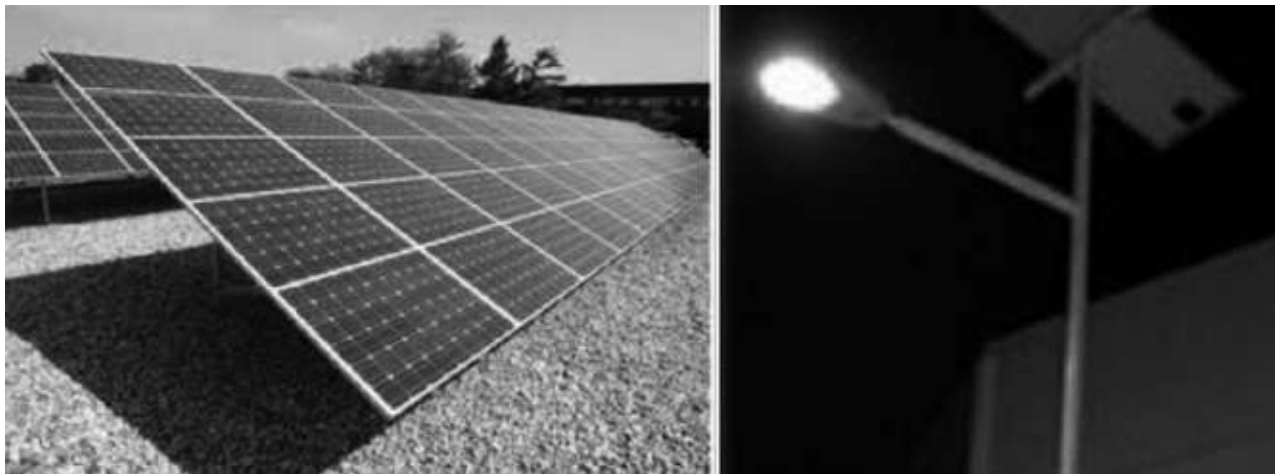
Figura 3. Aplicaciones de paneles solares en alumbrado público.
